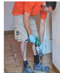
perçement des trous
