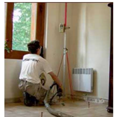
Relevage et contrôle
